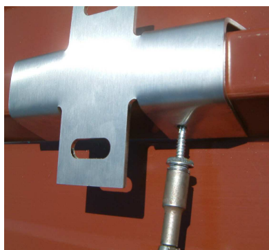
2. krok Sešroubování pomocí samopřezných šroubů
